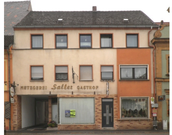
Hauptstraße mit Umbau mit Fassade im Zeitgeist
