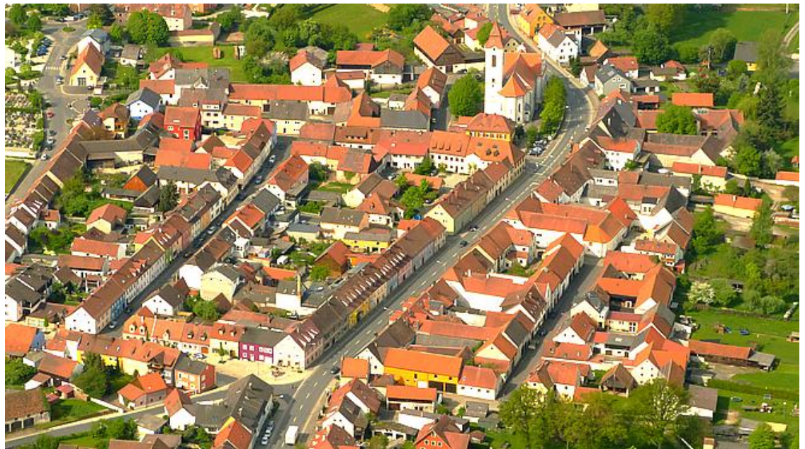
Altstadtensemble des historischen Stadtkerns
