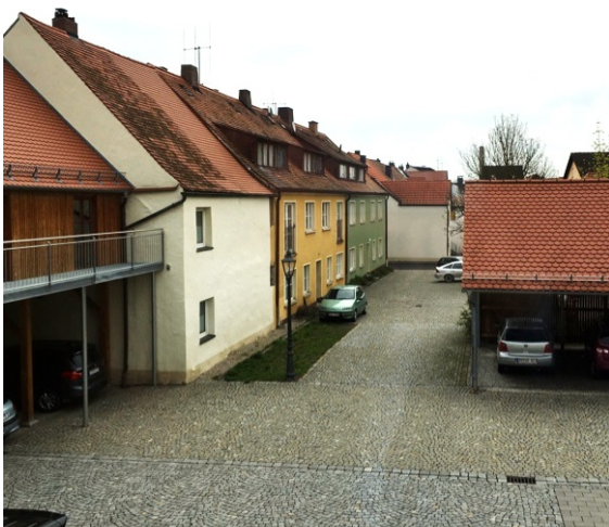
Südfassaden der städtischen Häuser
