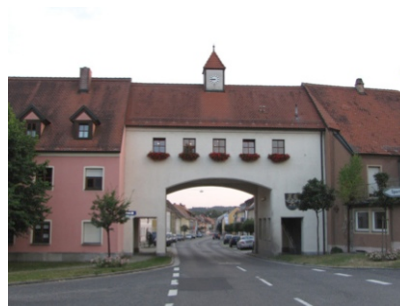
Referenzprojekt Hahnbach Oberes Markttor 1975 wegen Baufälligkeit abgebrochen 1990 unter „Berücksichtigung der Erfordernisse des Straßenverkehrs“ neu gebaut.
