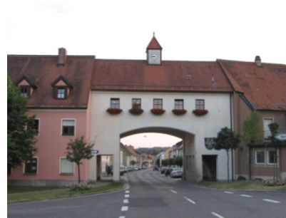
Referenzprojekt Hahnbach Oberes Markttor 1975 wegen Baufälligkeit abgebrochen 1990 unter „Berücksichtigung der Erfordernisse des Straßenverkehrs“ neu gebaut.
