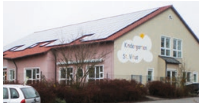
So wie auf dem Kindergarten St. Vitus sollen bald auf möglichst vielen Privatdächern PV-Anlagen installiert werden.
