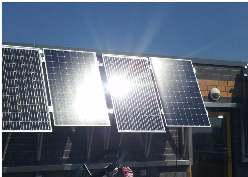
Abbildung 6: Veranschaulichung der Reflexion an einem texturierten Modulglas (mitte-links) und einem glatten Modulglas (mitte-rechts) – Quelle Aufnahme: Fraunhofer-Institut für Solare Energiesysteme ISE
