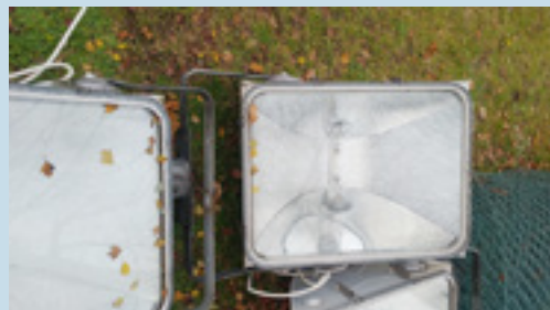
Alte Flutlichtanlage: Halogen-Quecksilber-Metalldampflampe
