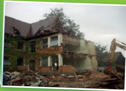
Abriss des Schulhauses „Auf der Loh“
